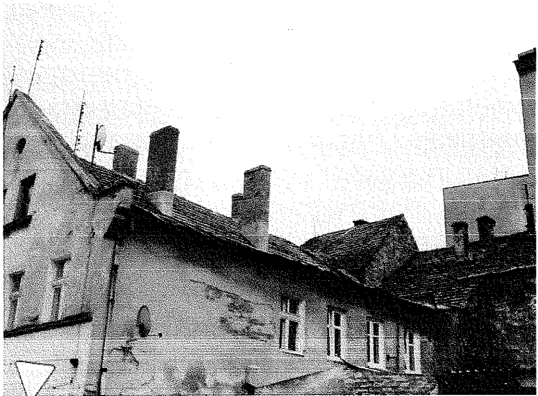
Zdjęcie nr 4 – Dach od strony podwórza
