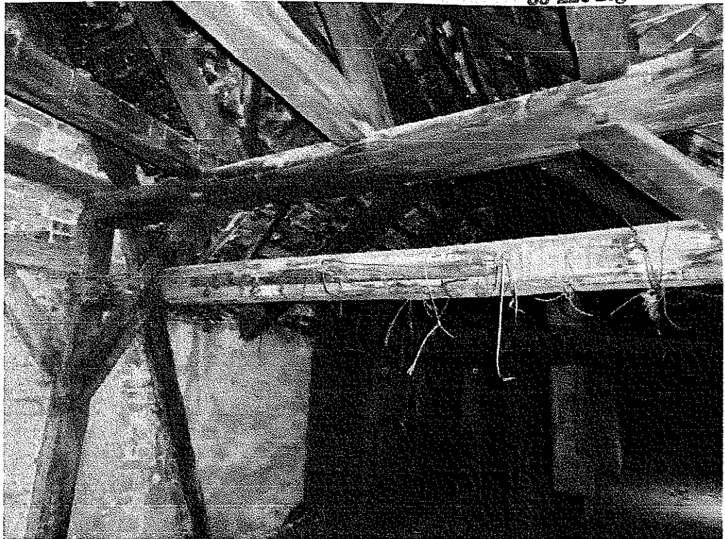
Zdjęcie nr 6 – Więźba dachu wyższego i niższego
