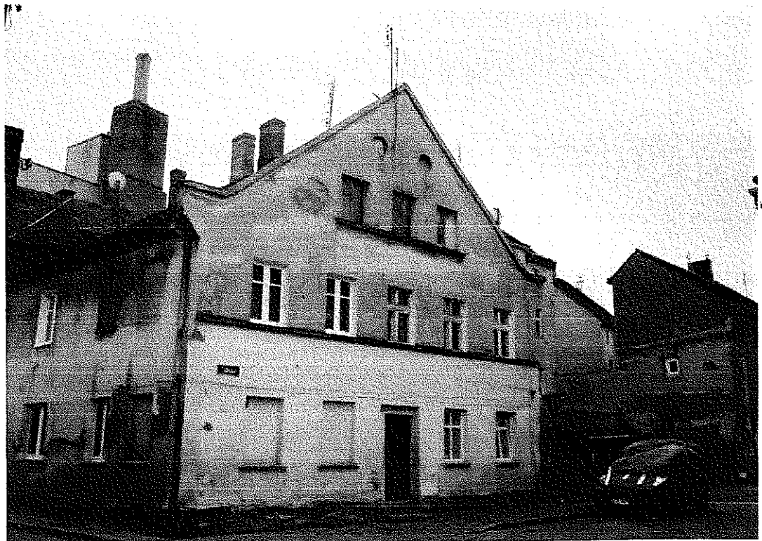
Zdjęcie nr 3 – Dach od strony ulicy Grottgera
