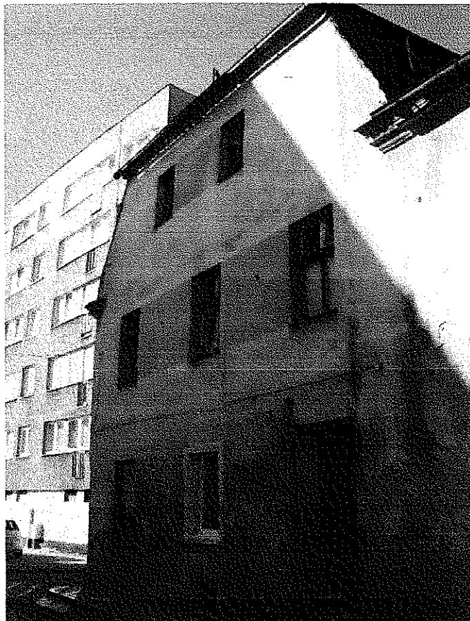
Zdjęcie nr 2 – Dach od strony ulicy Grottgera
