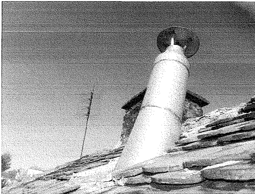
Zdjęcie nr 5 – Widok komina i rury spalinowej
