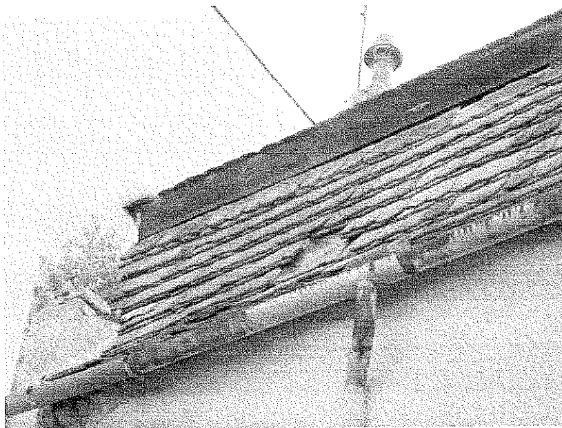
Zdjęcie nr 2 – Dach od strony podwórza
